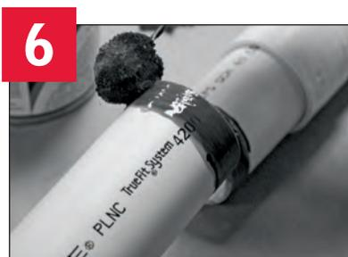
7. Empuje el cople de reparación hacia la abertura hasta que llegue a la marca en el otro extremo de la tubería. Un cordón de cemento permanecerá alrededor de todo el diámetro de la tubería y del cople.
