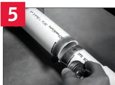
6. Aplique cemento de consistencia espesa entre la marca y extremo de la tubería en ambos extremos de las tuberías.
