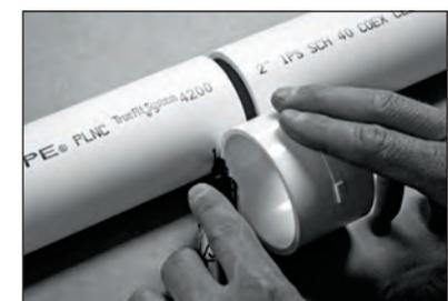
4. Coloque el cople de reparación en la tubería con el extremo de mayor DI (diámetro interior) mirando hacia la abertura entre los extremos de las tuberías. (El mayor DI del cople está marcado con una aleta realzada sobre la línea exterior del cople).
